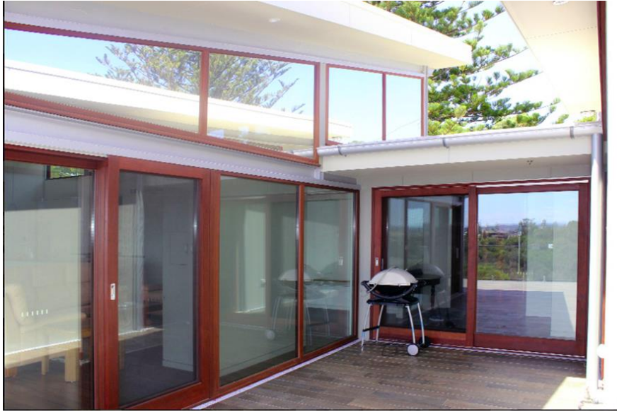
Figura 19 – Exterior de habitação com elementos envidraçados em portas de correr considerando o nível de ataque ao incêndio florestal BAL-40.
