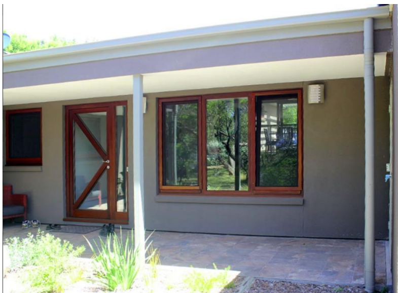
Figura 21 – Exterior de habitação com paredes em alvenaria e revestimento em argamassa, com elementos envidraçados em porta de entrada e janela considerando o nível de ataque ao incêndio florestal BAL-40.
